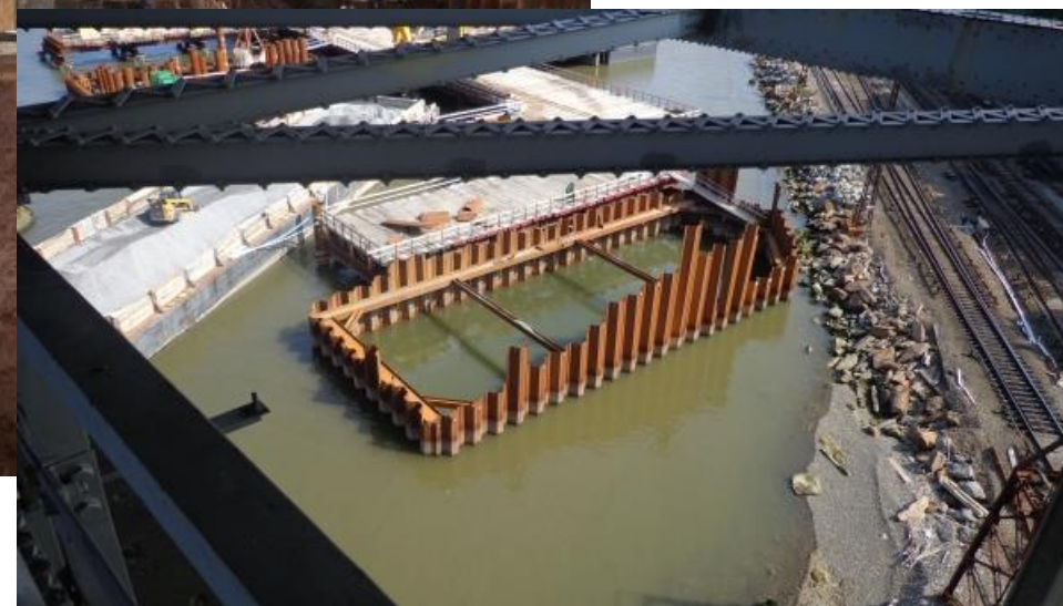
Courtesy: Siefert Associates
